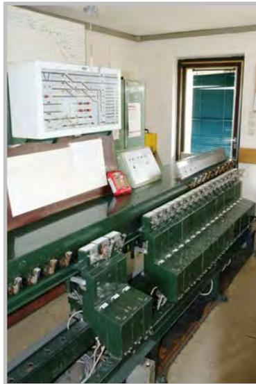
**Foto unten:** Die Sicherungsanlage im Stellwerk 2 (Bj. 1930) war ein Exot, ein elektromechanisches Stellwerk der Bauart 42733. Die Weichen sowie die Fahrstraßenfestlegung erfolgte mit den im Bild sichtbaren Hebeln. Am kleinen Pult oberhalb war schematisch der Gleisplan abgebildet und die Stellung der elektrischen Weichen ersichtlich. Gleisfreimeldung gab es, bis auf die Weichenbereiche, keine.
