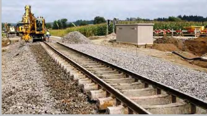
Foto oben: Bauzustand im Bereich der EK in km 16,200 am 15.08.2008 gegen Mittag. Rechts ist die neue Schaltstation der EK-Sicherungsanlage zu erkennen, das Streckengleis wird noch etwas nach rechts verschwenkt.
