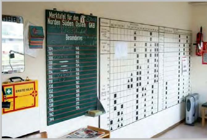
**Foto oben:** Im Weichenposten 1 am Verschiebebahnhof Gösting versah die Mutter aller Sicherungsanlagen, ein Schlüsselbrett, ihren Dienst. Sämtliche Weichen der Südausfahrt wurden per Hand gestellt, Gleisfreimeldung gab es keine.
