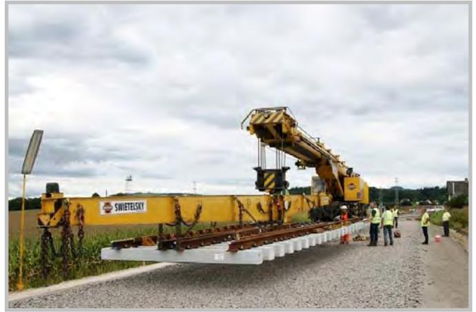
Foto oben: Stück für Stück wird am 16. 08. 2008 die Weiche 10 vom Schienenkran an den Einbauort gebracht.
