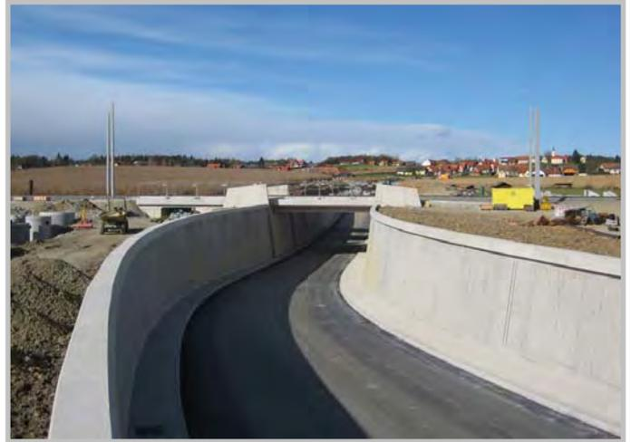
Foto oben: Das Unterführungsbauwerk der ehemaligen EK in km 18,112 kurz vor der Verkehrsfreigabe. Man vergleiche die Aufnahmen in der Drehscheibe 37 & 38!
