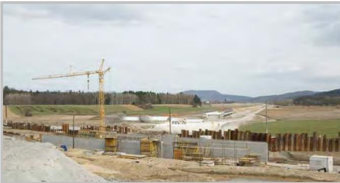
Foto unten: Mit der Hochleistungsstrecke tauchen nun auch erstmals Lärmschutzwände in größerem Umfang bei der GKB auf. Links neben dem VT 70.02 sind schon die Steher zu erkennen, die Schallschutzelemente werden aber erst zu einem späteren Zeitpunkt eingebaut.
