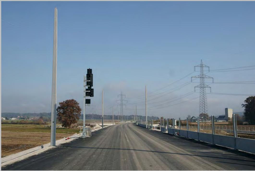
Foto links: Aus Richtung Werndorf steht das Einfahrsignal „A“ ebenfalls schon, jedoch fehlen noch die Gleise. Der Weiterbau der Gleisanlagen ist für das 1. Quartal 2010 vorgesehen.
