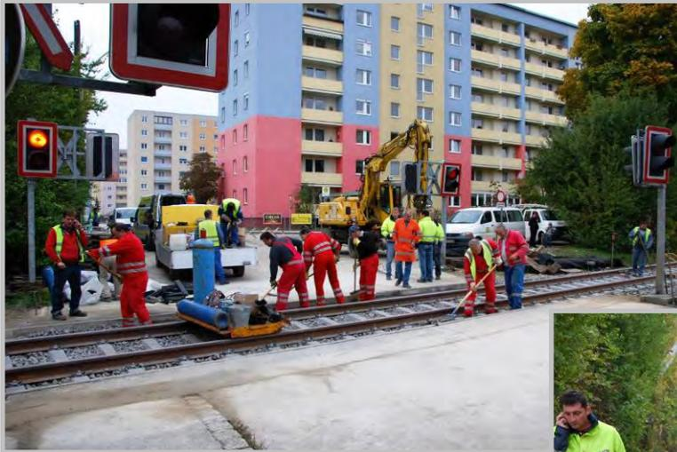
oben: 26. 10. 2009, 14:56: Im Bereich der EK Grottenhofstraße (km 3,296) werden die Vorbereitungsarbeiten für den Einbau der Gleiseindeckung durchgeführt.
