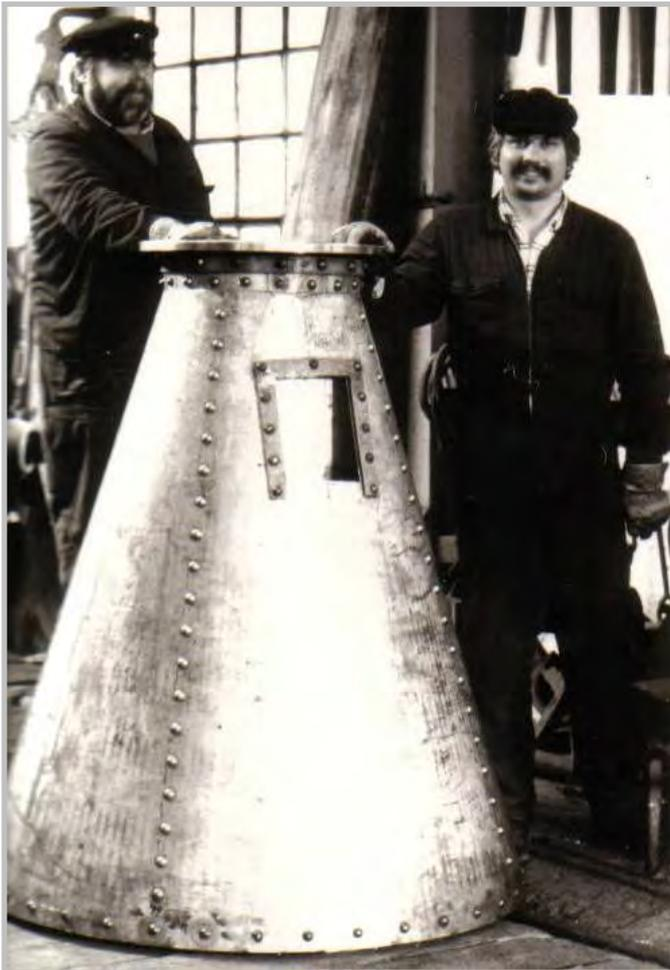
Foto oben: Der neue Kegel am 8. 4. 1988 nach Zeichnung von DI Dr. Erich Stadlober, gebogen von der Fa. Tschuda, geschweißt in der GKB - Werkstätte. (Foto Tezak)
