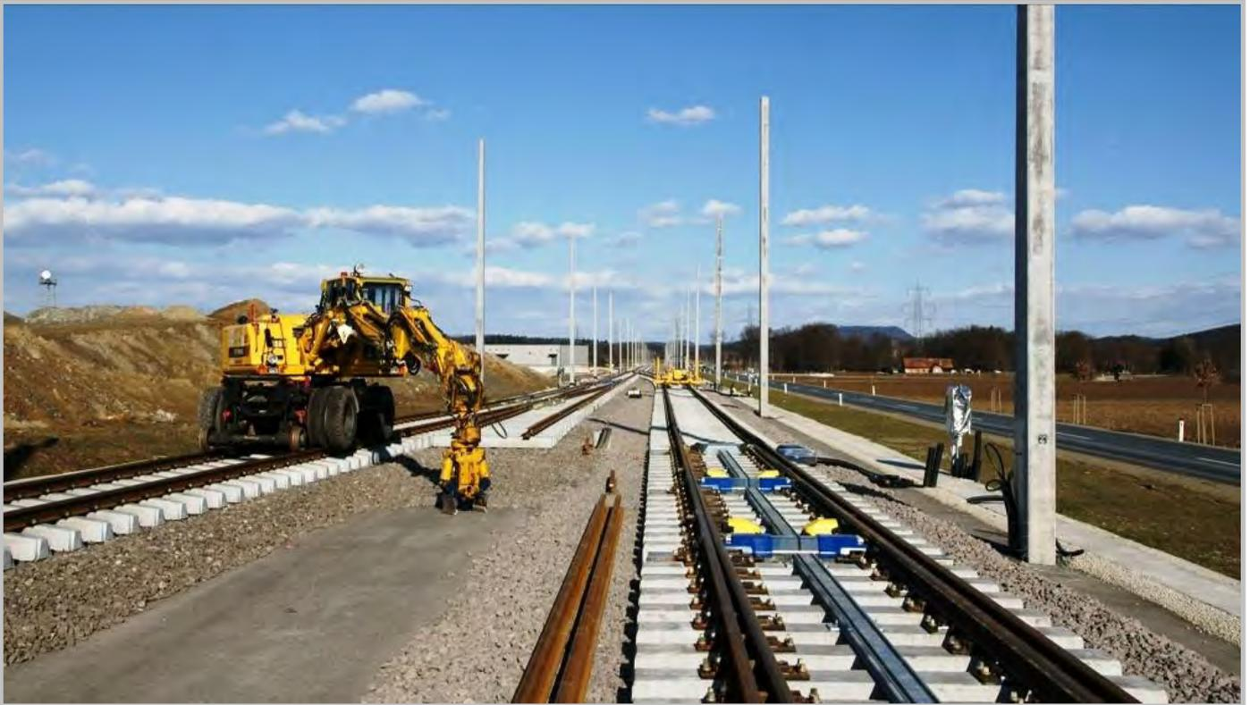
**Foto oben:** Ostkopf Bahnhof Wettmannstätten. Die vier Weichen 7, 6, 5 und 4 sind Schnellfahrweichen und können in die Gerade mit 200 km/h befahren werden. Links hinten ist das Technikgebäude (u.a. für das Stellwerk) erkennbar.
