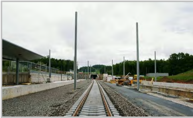
Foto oben: Am 13. Mai 2010 am frühen Nachmittag war es soweit, der Bahnhof Hengsberg kann nun auch auf der Schiene erreicht werden. Das Bild zeigt das Gleisende Richtung Hengsbergtunnel, Ende Mai wurden noch die beiden Weichen mittels Schienenkran verlegt.
