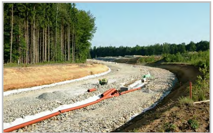
oben: Bauzustand Anschlussbahn Leibenfeld Anfang Juni 2010 mit Blickrichtung Gleisende. Insgesamt sind drei Gleise projektiert, rechts hinten werden sich die Anlagen für die Verladung des Abraummaterials des Koralmtunnels befinden.
