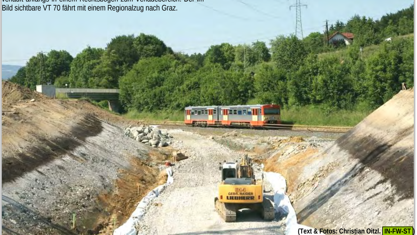
oben: Bauzustand Anschlussbahn Leibenfeld Anfang Juni 2010 mit Blickrichtung Gleisende. Insgesamt sind drei Gleise projektiert, rechts hinten werden sich die Anlagen für die Verladung des Abraummaterials des Koralmtunnels befinden.
