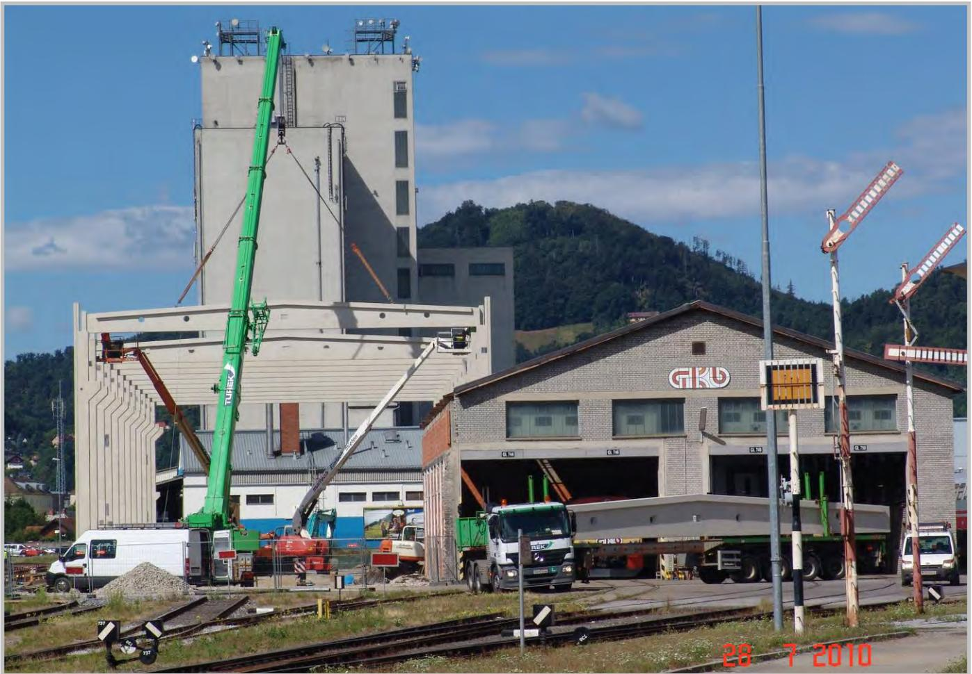
Foto oben: Die Konturen der neuen Servicehalle sind nun klar erkennbar, rechts vorne vor dem erhalten gebliebenen Altbestand wird gerade der letzte Dachträger angeliefert, der sofort mit dem Kran an seine endgültige Position gehoben wird. (Foto: 28. Juli 2010, Alois Wallner, EB-PV)
