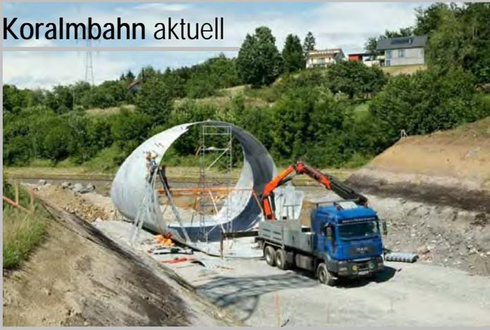
Foto links oben: In der 2. Junihälfte wurde mit dem Zusammenbau des Stahlrohrdurchlasses bei der AB Leibenfeld begonnen. Diese Art eines Durchlasses ist bei der GKB nicht neu, jedoch wird erstmals ein Zug durch diesen Durchlass fahren und nicht darüber. Entsprechend groß ist auch der Querschnitt.
