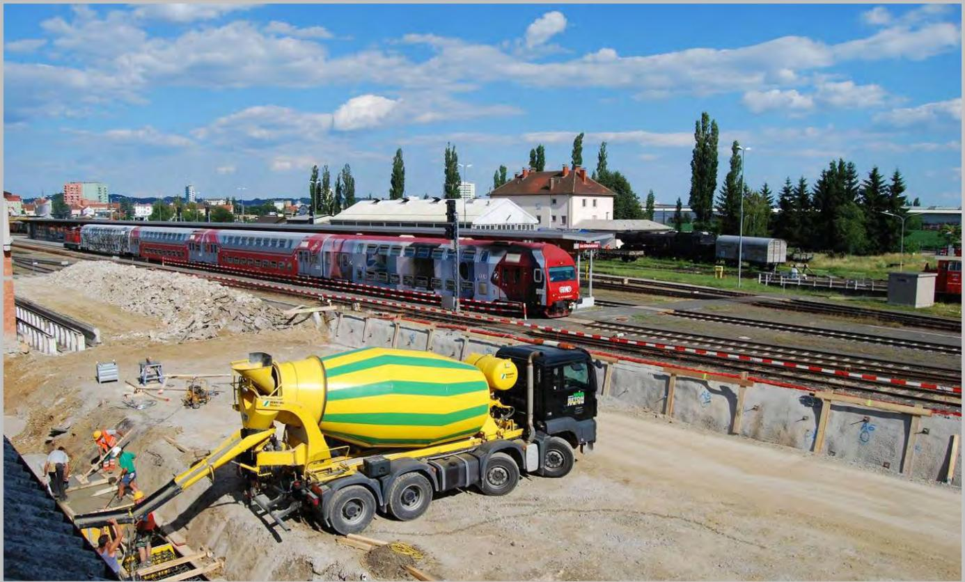
Foto oben: Nach dem Abbruch wurde der Bauschutt zerkleinert und die Fundamente für die Stützen betoniert.
