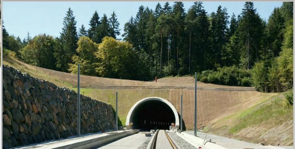
Foto rechts: Mitte Juli wurde die letzte Gleislücke im Hengsbergtunnel geschlossen, somit ist die Strecke Werndorf – Wettmannstätten durchgängig befahrbar. Das Foto zeigt das Ostportal mit Gleiselementen der Festen Fahrbahn.
