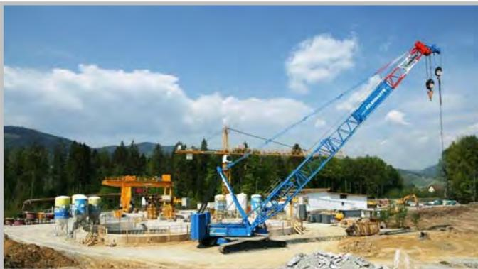
Foto oben: Bei der Tunnelbaustelle in Leibenfeld gibt es sehr interessante Baugeräte zu sehen. Wie hier ein Gittermastkran auf einem Raupenfahrwerk.
