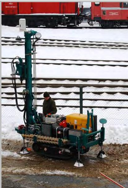
Die Bomben aus dem II. Weltkrieg bedingen auch heute noch bei jedem Bauvorhaben umfangreiche Sondierbohrungen, wobei durch Spezialisten der Bauplatz vor Beginn der eigentlichen Grabungsarbeiten auf verdächtige Relikte im Erdreich untersucht wird. Beim Neubau der Servicehalle wurden diese Sondierarbeiten im Jänner 2010 durchgeführt. (Foto links: Bohrmaschine im Einsatz auf dem zukünftigen Hallenbauplatz am 14. Jänner 2010)
