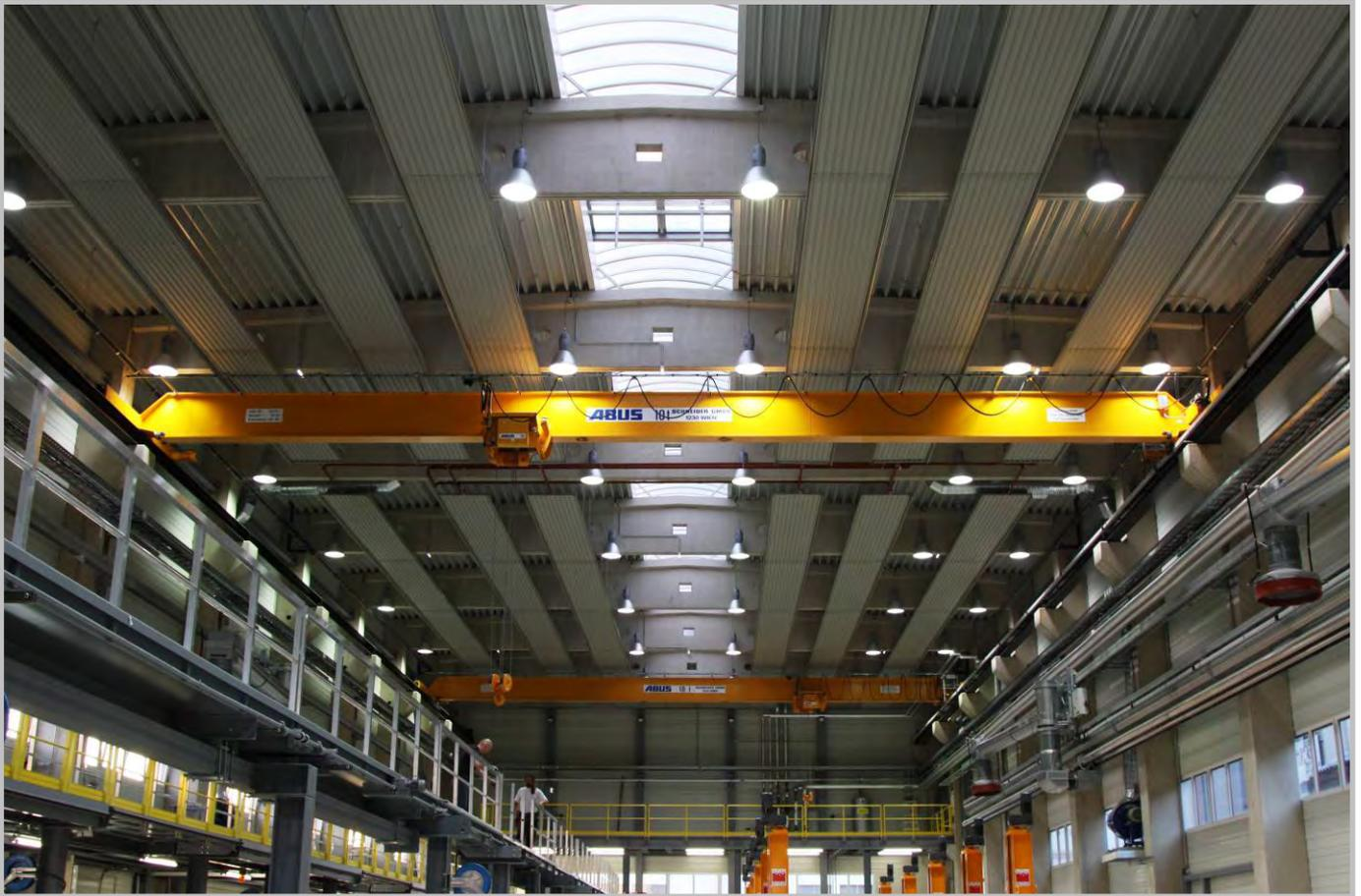
Foto oben: Ein Blick nach oben zur Hallendecke von Ost nach West. Links die Dacharbeitsbühne, oben die beiden Einträgerlaufkräne und die Dachkonstruktion. Durch die durchgehenden Fensterlinien an den Wänden und an der Decke ist rundum für Tageslicht gesorgt.
