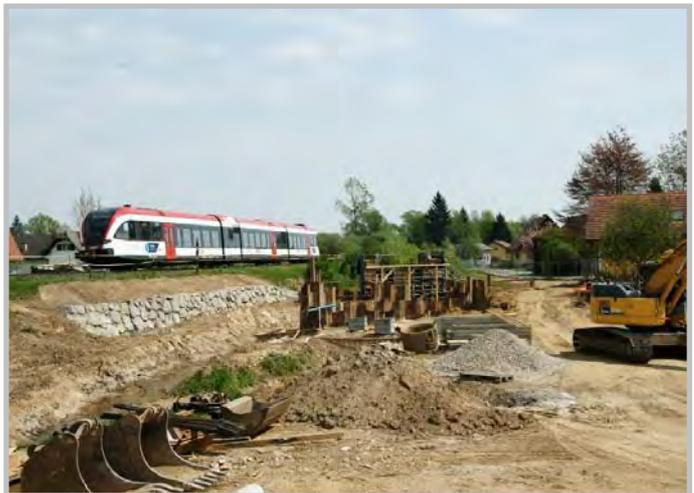
Foto oben rechts: Nahe dem Bahnhof Groß St. Florian haben die Arbeiten am Verbindungsgleis zum Bahnhof Weststeiermark begonnen. Rechts vom GTW sind die Spundwände und Schalungen für ein Brückenbauwerk zu sehen.
