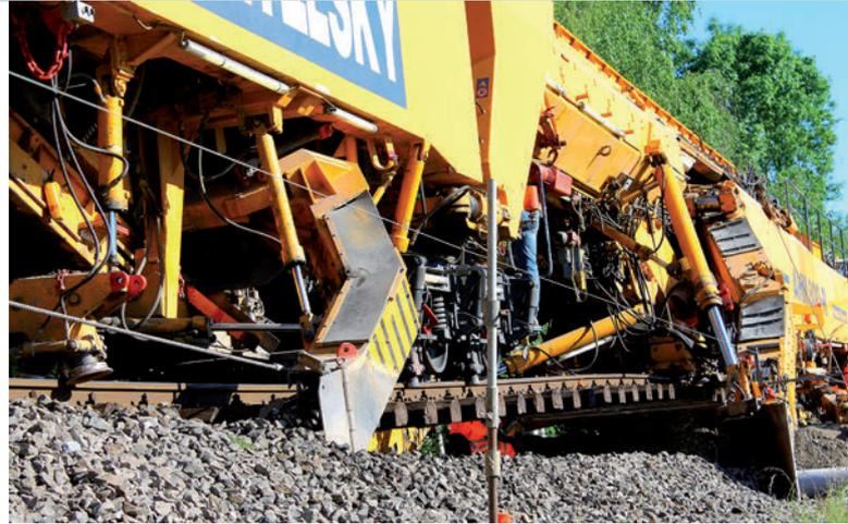
Die Gleisbaumaschine hebt den Gleiskörper und saniert das Schotterbett
