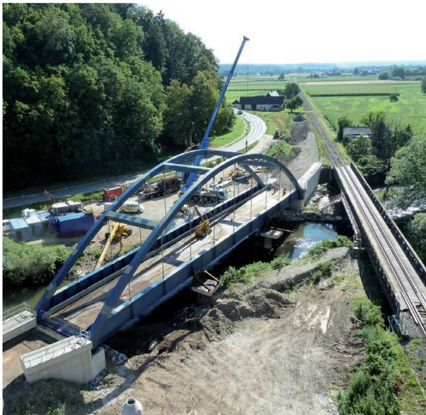
Neue Stahlbogenbrücke vor der Fertigstellung - daneben sieht man die alte Stahltrugbrücke
