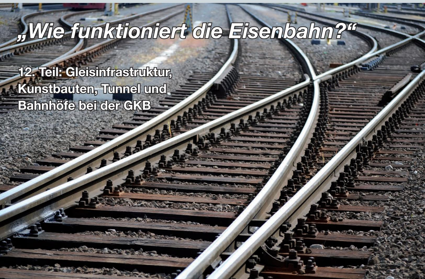
Lückenlos verschweißtes Bahnhofsgleis in Weiche mit einem (Laschen-)Isolierstoß für die außer Betrieb genommene Gleisfreimeldeanlage
