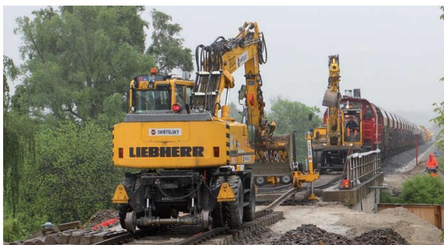
Zweigegefahrzeuge bei einer Gleisbaustelle mit einem Durchlass bei Deutschlandsberg
