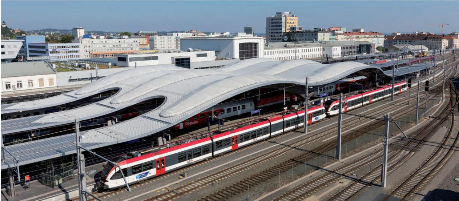
Gelenktriebwagen der GKB am neuen Bahnsteig 6/7 mit seinem modernen, offenen Wellendach mit LED-Beleuchtung
