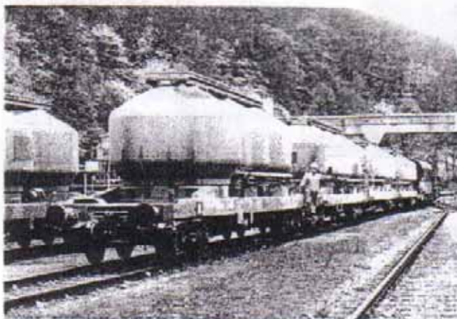
Beim Vershub von Privatwagen der Fa Holcim (Wien) in Waldmühle
