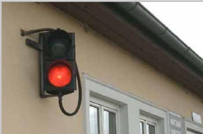
Foto oben: 14. Juli 2005, 8.48 Uhr: Nur noch wenige Minuten, dann ist der „Spezial“-Signalnachahmer am Aufnahmsgebäude Geschichte. Weiters sind zwei weitere GKB-Besonderheiten dem ESTW zum „Opfer“ gefallen. Die Vorsignale mit jeweils nur einer Gelb- und Grünlichtlampe sowie die „EK-Kontrolllichter“ der EK in km 1,837 (Wetzelsdorfer Straße).
