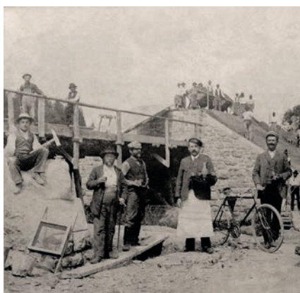
Beim Bau kam kaum Technik zum Einsatz
