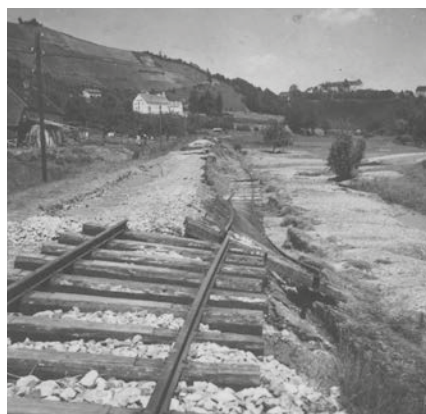
Hochwasserschaden bei Silberberg
